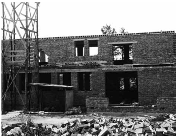
Hrubá stavba mateřské školy v roce 1973
