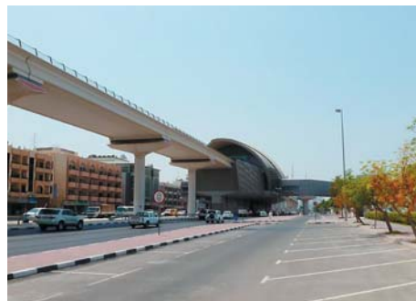
Metro - nadzemní dráha, vzadu hala zastávky
